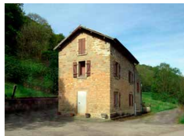
Passage à niveau de Moestroff (essai de reconstitution du bâtiment tel que Jean Wolff l'a connu)
