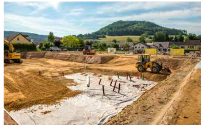
Terrassementsaarbechte fir eis zwou Residence mat der SNHBM sinn am gaangen.
