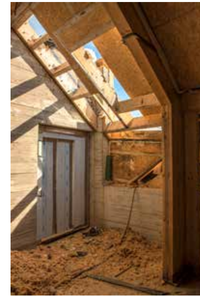
Ofrapp- an Opbauaarbechte vun der Maison Relais si säit März am gaangen.
