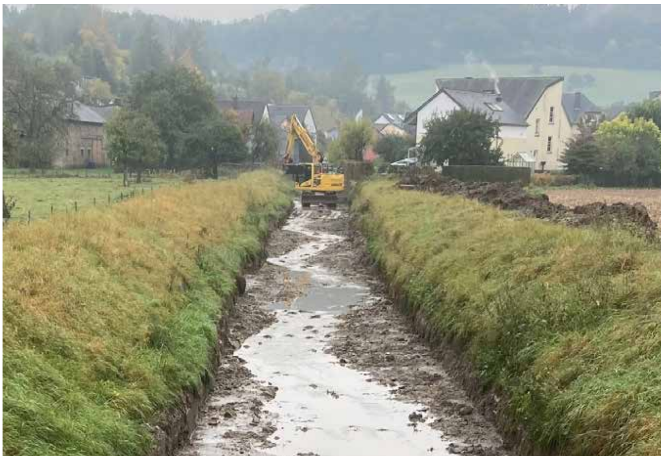
Ausbaggerarbeiten an der Tirelbaach zu Gilsdref.
